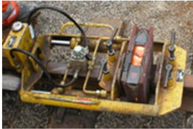
Slika 32 Hidrauličko uklanjanje kalupa i viška materijala [4]
