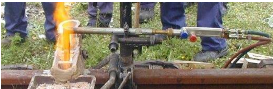
Slika 19 Predgrijavanje plinskim plamenom [16]
