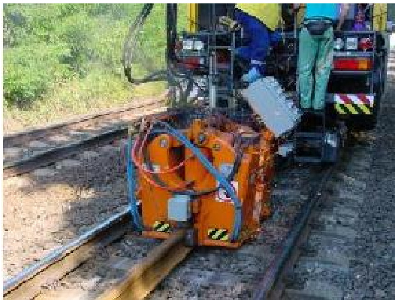
Slika 12 Elektrootporno zavarivanje tračnica [11]
