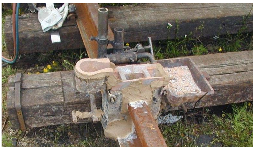
Slika 26 Postavljanje kalupa na mjesto spoja
