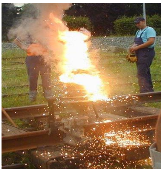
Slika 30 Aluminotremijska reakcija u tiglu [16]
