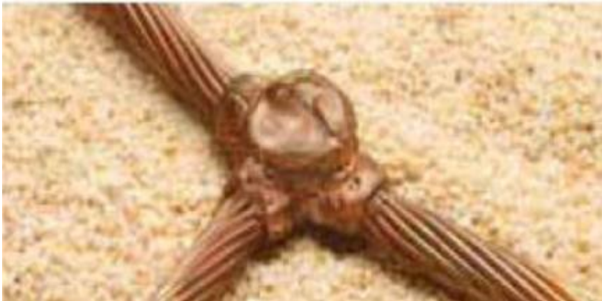
Slika 24 Zavarivanje bakrenih vodiča [18]
