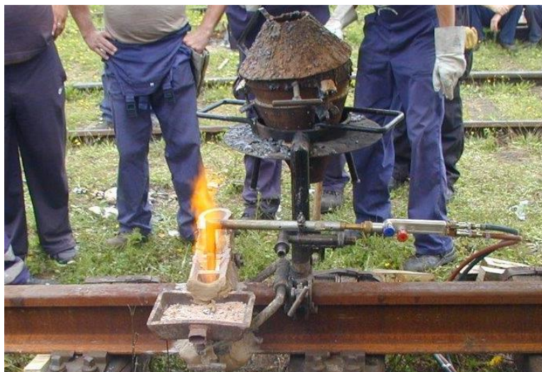
Slika 29 Predgrijavanje kalupa i krajeva tračnica prije zavarivanja [16]
