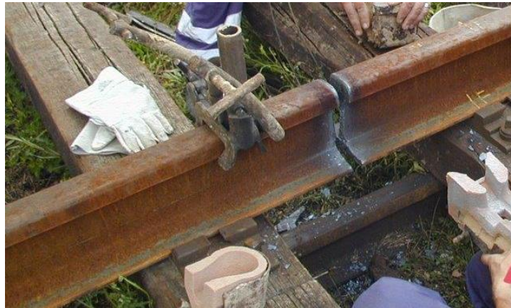
Slika 25 Priprema spoja i položaj tračnica prije zavarivanja [16]
