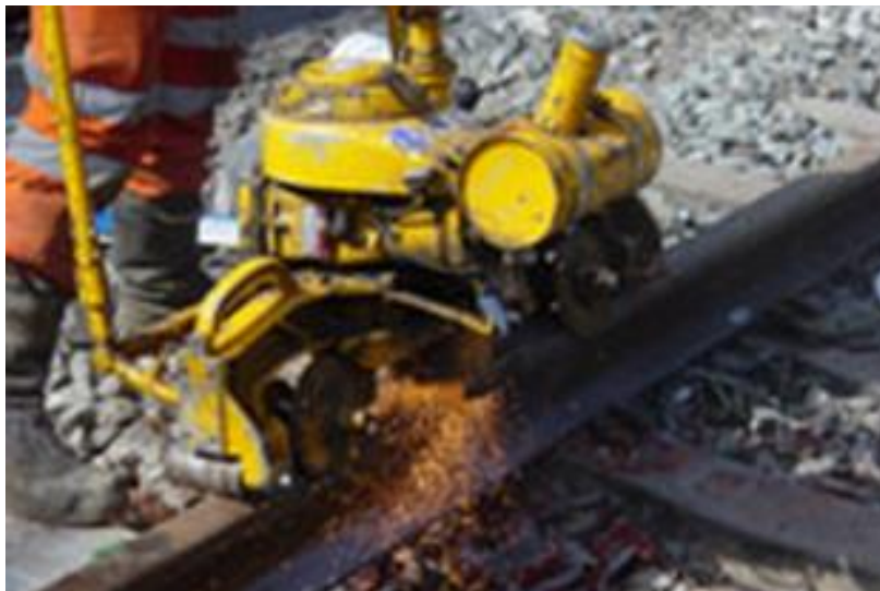
Slika 33 Završno brušenje tračnica [4]
