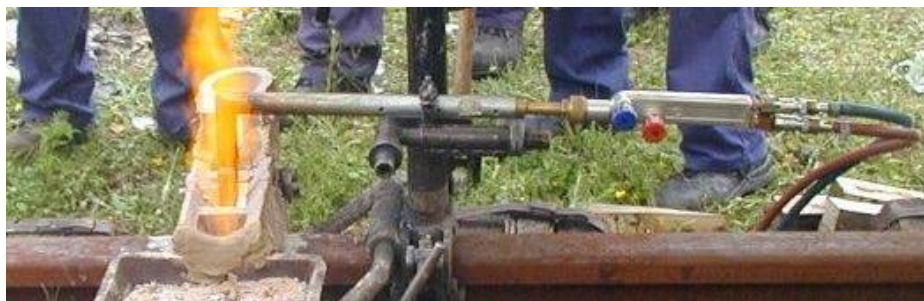
Slika 19 Predgrijavanje plinskim plamenom [16]
