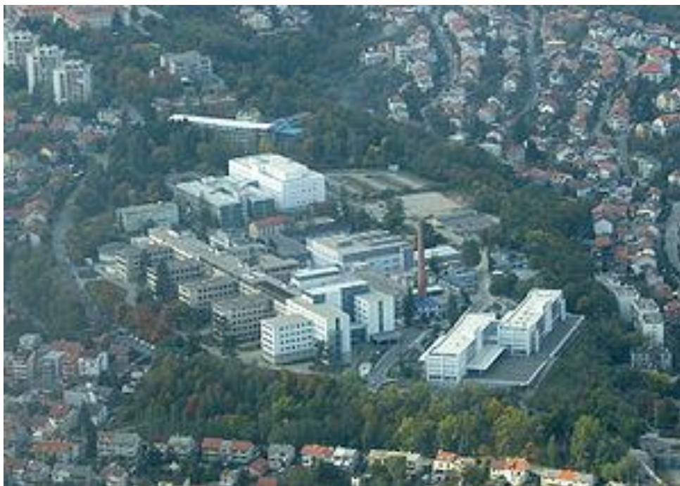
Slika 17. KBC Zagreb na lokaciji Rebro
