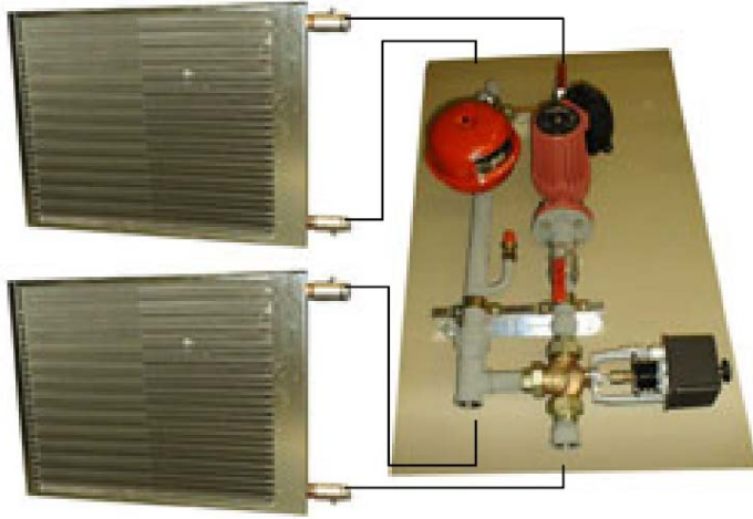
Slika 7. Kružni cirkulacijski sustav povrata topline
