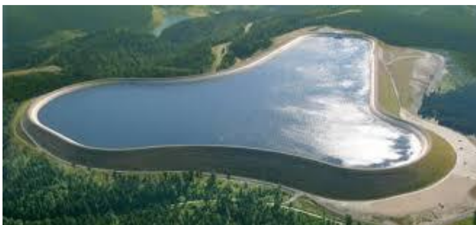
Slika 2. Otvorena izvedba gornje akumulacije[3]
