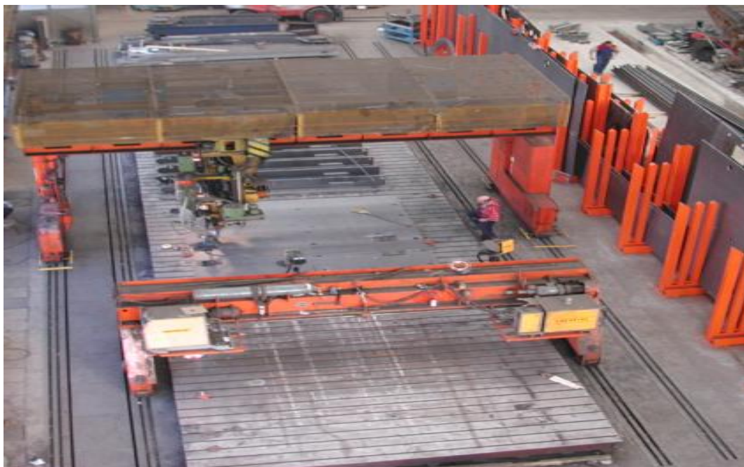
Slika 18. Postupak zavarivanja u velikoj proizvodnoj hali
