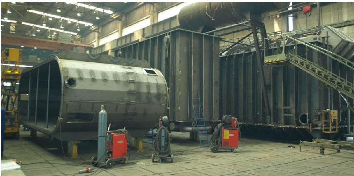
Slika 6. Transformatorski kotao u montaži
