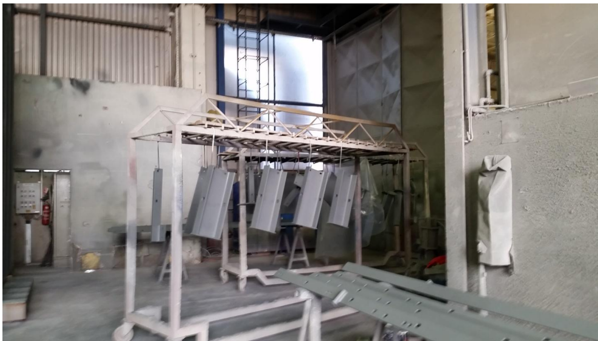
Slika 28. Sušenje manjih dijelova nakon završnog (trećeg) sloja
