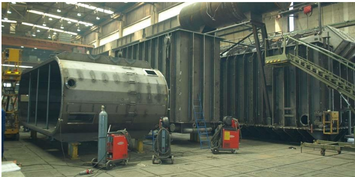
Slika 6. Transformatorski kotao u montaži
