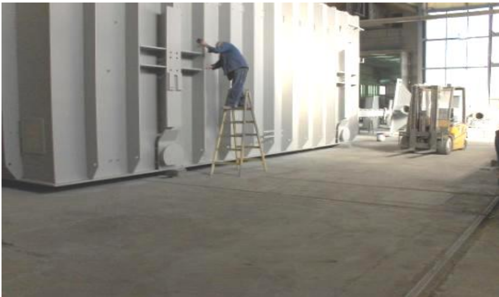
Slika 21. Lakiranje (nanošenje antikoroziivnog premaza)
