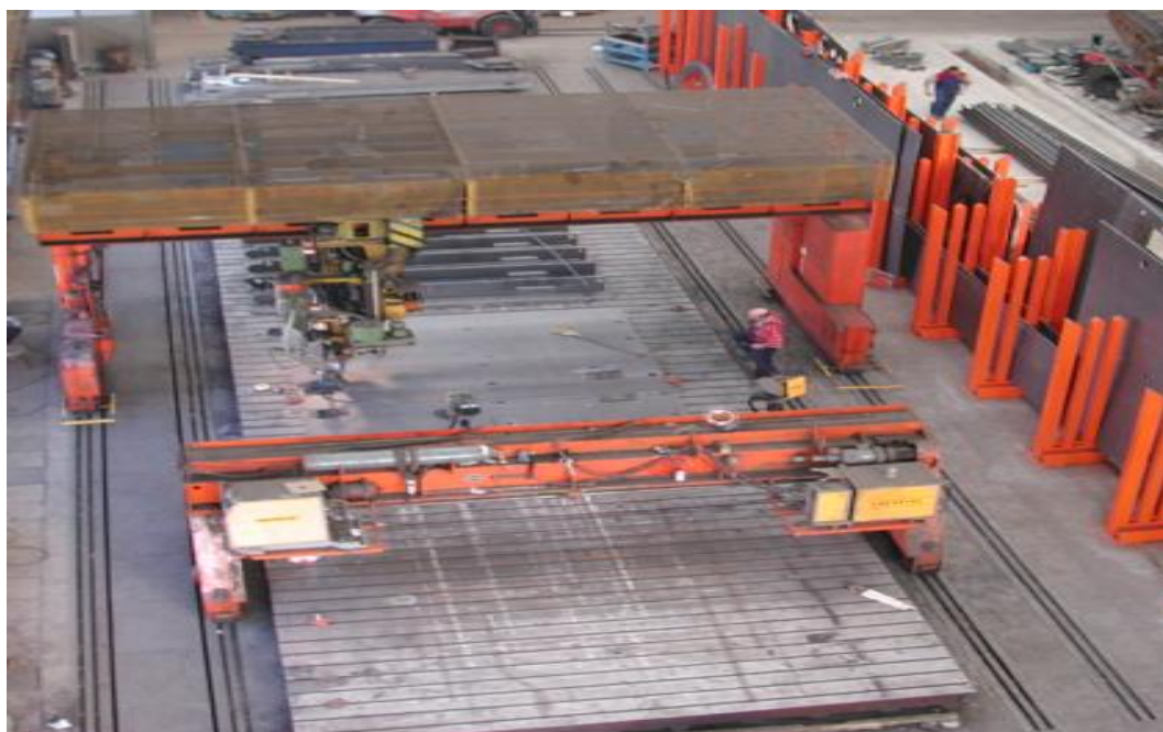
Slika 18. Postupak zavarivanja u velikoj proizvodnoj hali
