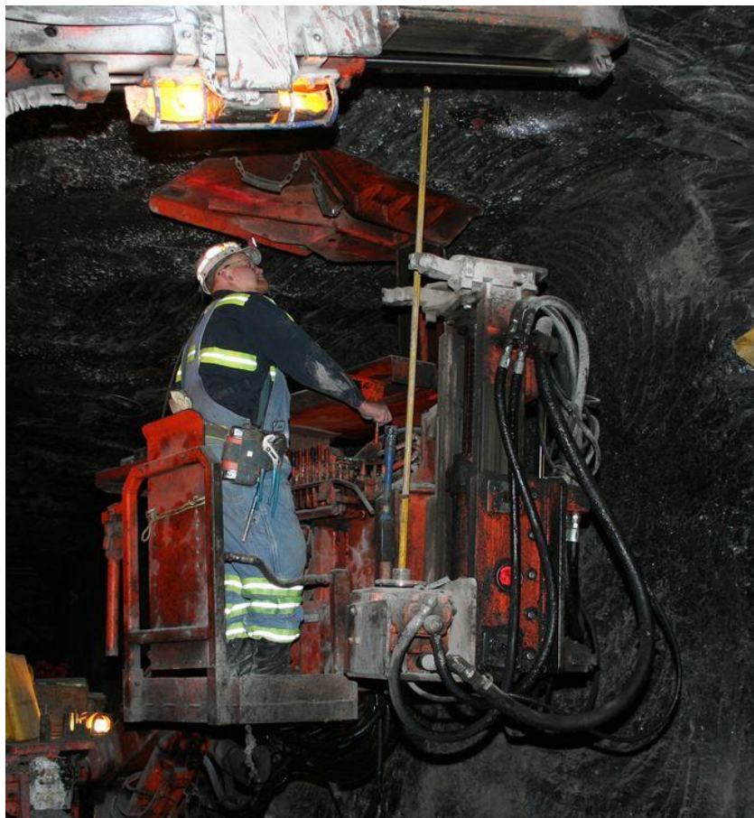
Slika 16. Ručno postavljanje sidra
