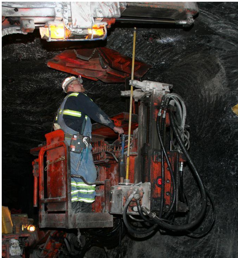
Slika 16. Ručno postavljanje sidra
