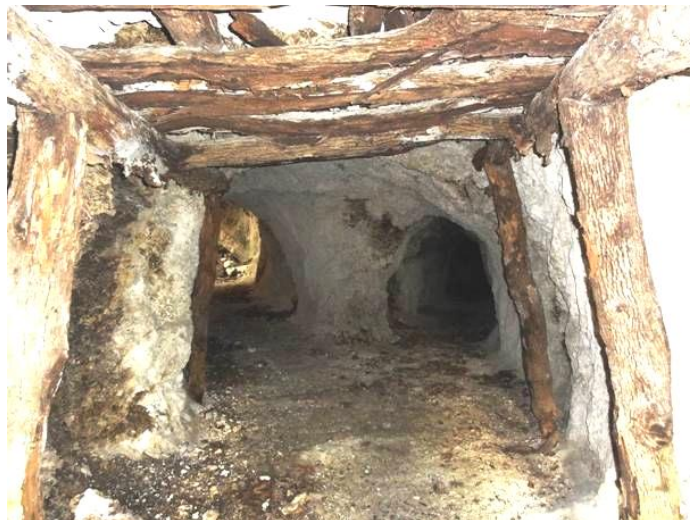
Slika 6. Drvene podgrade u rudniku
