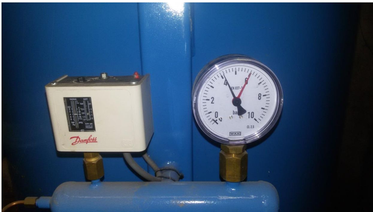
Slika 9. Sigurnosni sustav hidrofora- TS FSB Jug-Neboder
