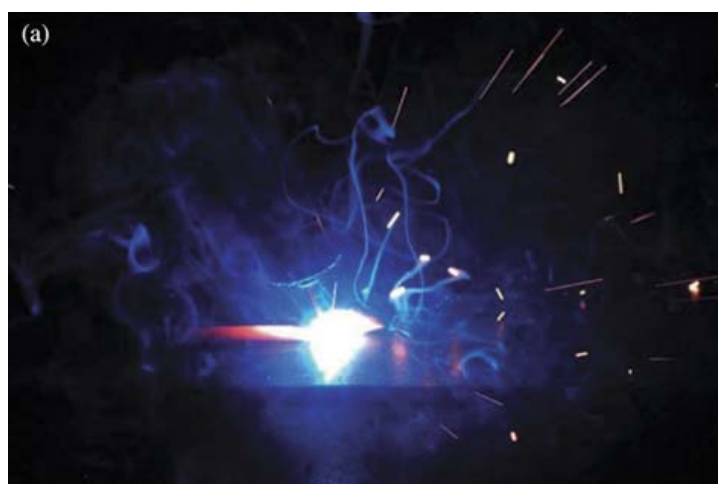
Zavarivanje bez preciznog predviđanja pojave električnog luka
