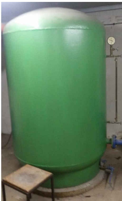
Slika 18. Hidrofor za napajanje 'mokrog' hidranta
