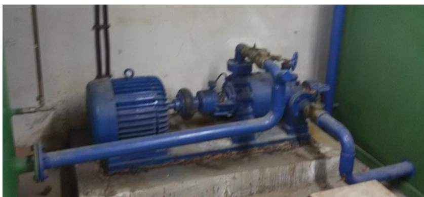
Slika 17. Motor za crpljenje vode iz spremnika
