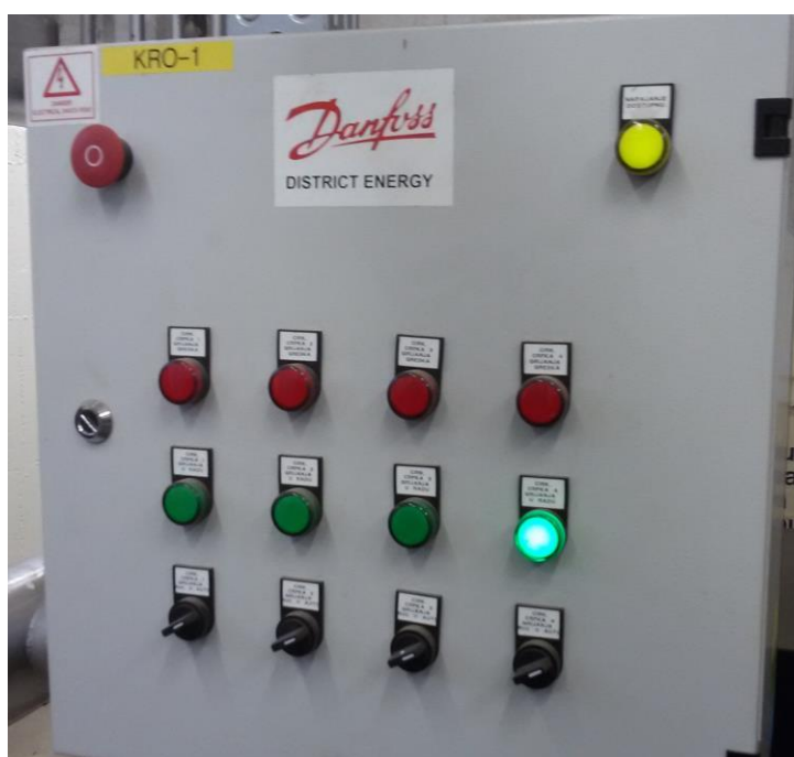
Slika 8. Indikatori i prekidači izmjenjivača topline
