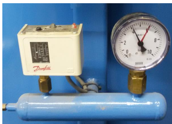
Slika 11. Nazivni tlak hidrofora
