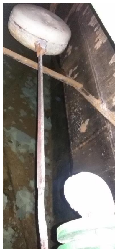
Slika 15. Plovak za regulaciju visine vode
