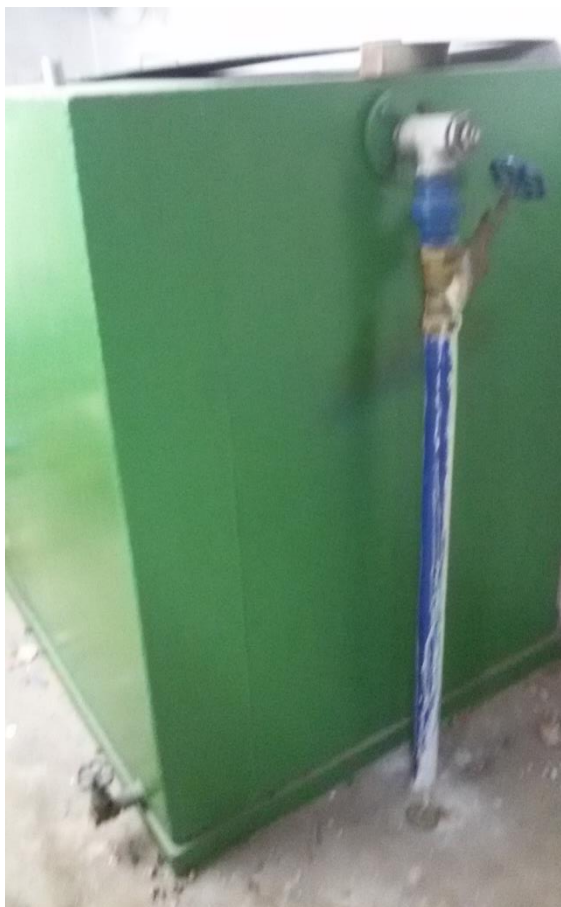
Slika 16. Spremnik zapremnine 3000 litara
