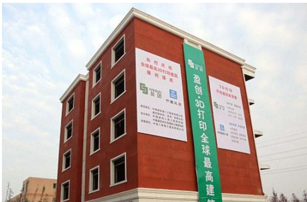
Slika 6.7. Zgrada izgrađena 3D tiskanjem
