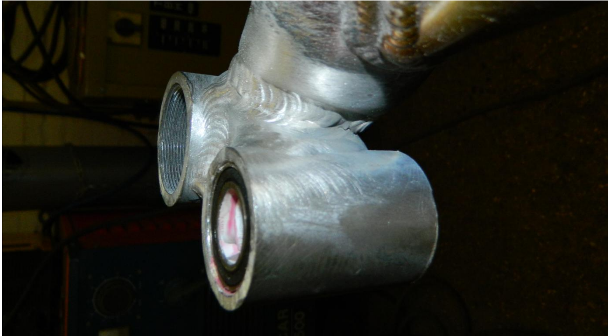
Slika 29. Izgled zavara nakon reparature (pogled s lijeva)
