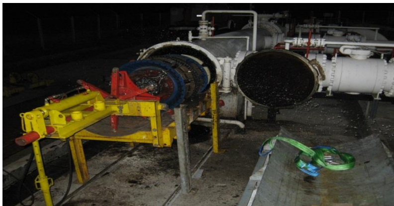
Slika 30. Lansiranje piga u naftovod hidrauličkom prešom, [11]
