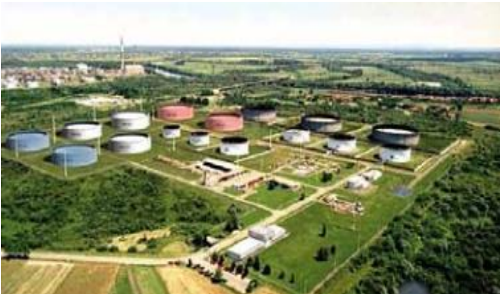
Slika 14. Spremnici za skladištenje nafte u Sisku, [11]
