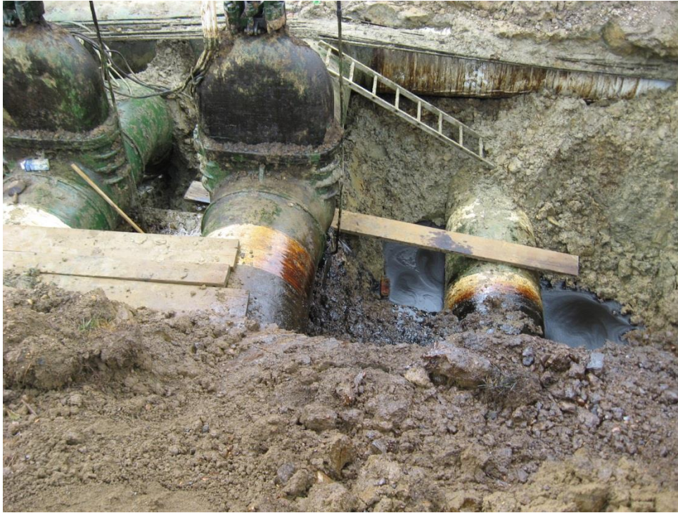
Slika 35. Sanacije cijevi koja propušta naftu, [11]
