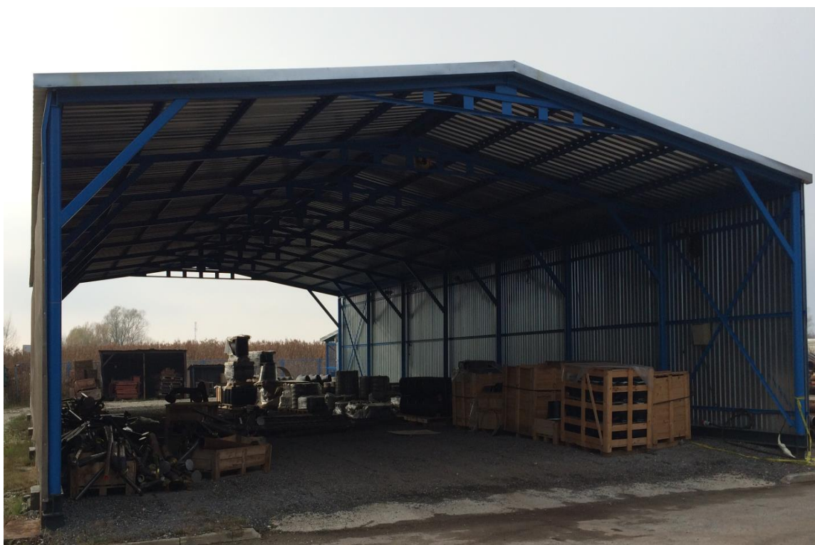
Slika 36 Natkriveno skladište poduzeća Monting d.o.o.
