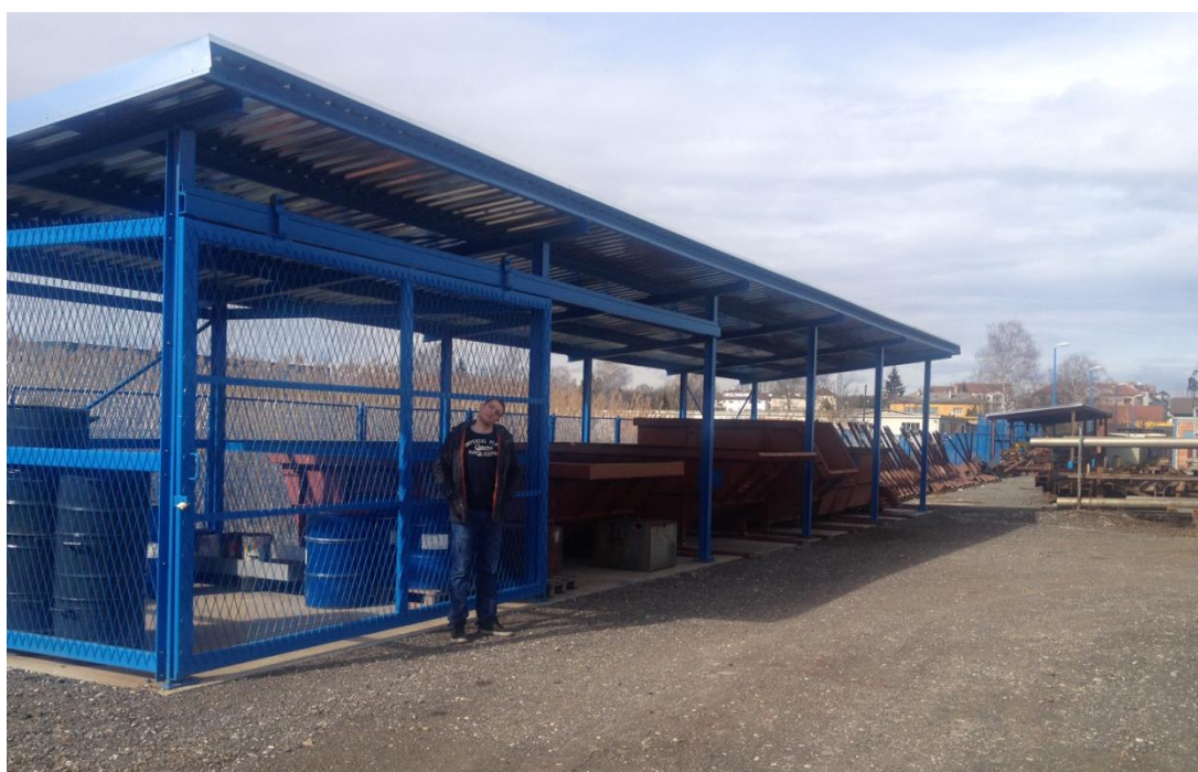
Slika 18 Skladište otpada u poduzeću Monting d.o.o.
