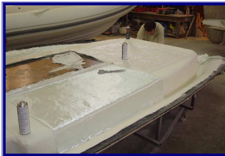
Slika 4.19 Postavljanje završnog sloja laminata palube
