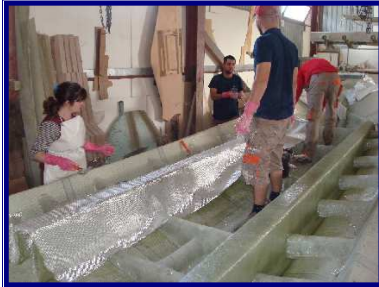
Slika 3.5 Postavljanje i učvršćivanje roštilja dna
