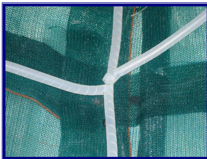
Slika 4.14 Postavljanje cjevovoda smole
