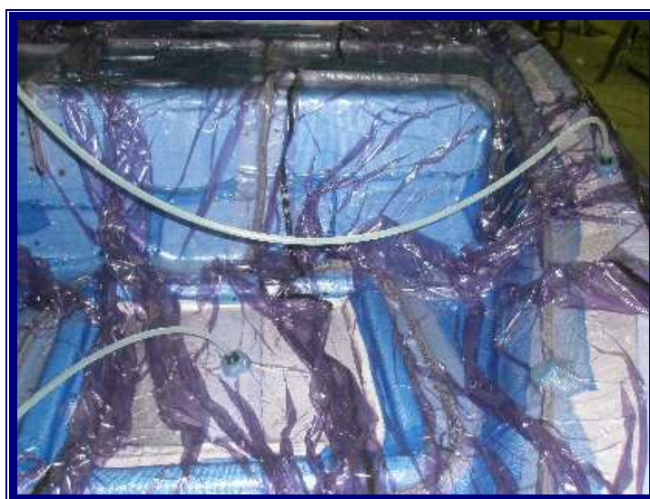
Slika 4.23 Postavljanje vakuumskih cjevovoda
