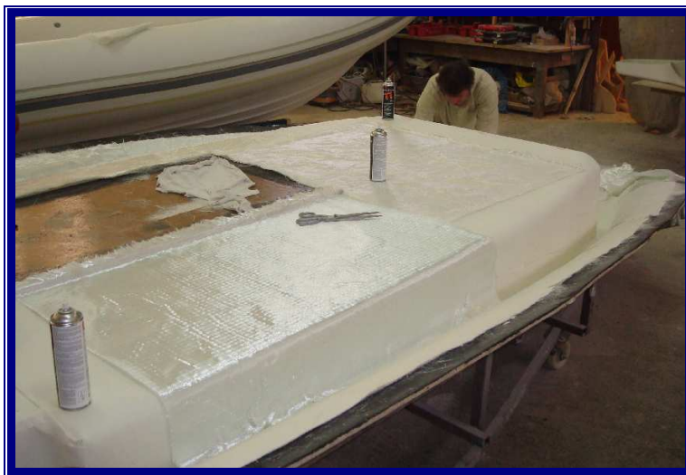
Slika 4.19 Postavljanje završnog sloja laminata palube
