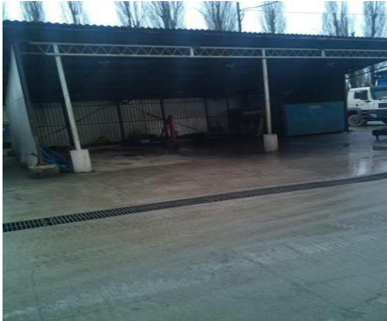
Slika 21 – Autopraona poduzeća Viadukt d.d.
