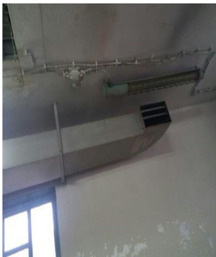
Slika 24 – Upuhivanje toplog zraka
