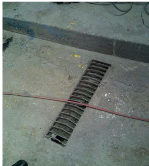
Slika 25 – Odvod onečišćenog zraka
