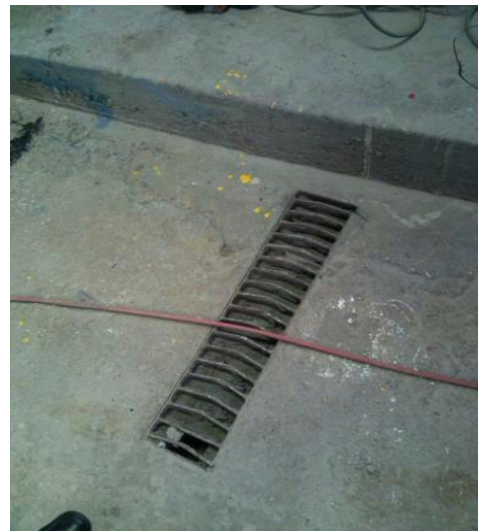
Slika 25 – Odvod onečišćenog zraka
