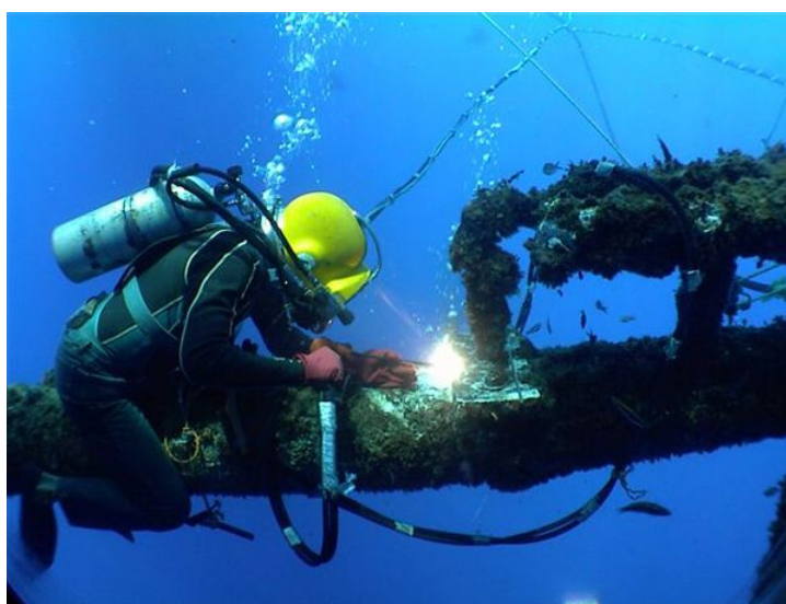
Slika 2.3.4 Mokro podvodno zavarivanje [47]
