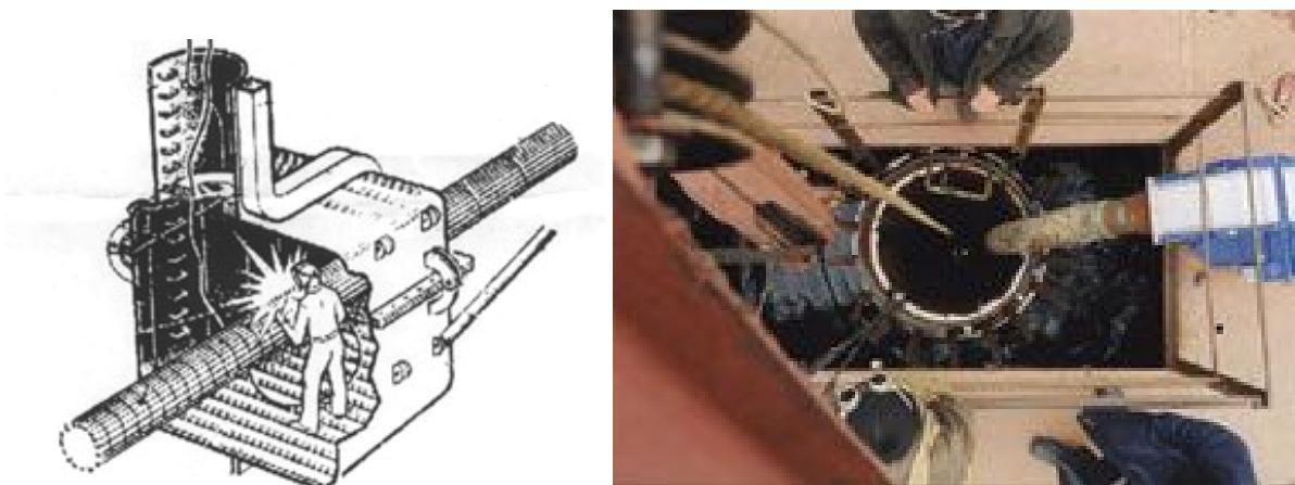
Slike 2.3.3 Podvodno zavarivanje pri atmosferskom tlaku [44]
