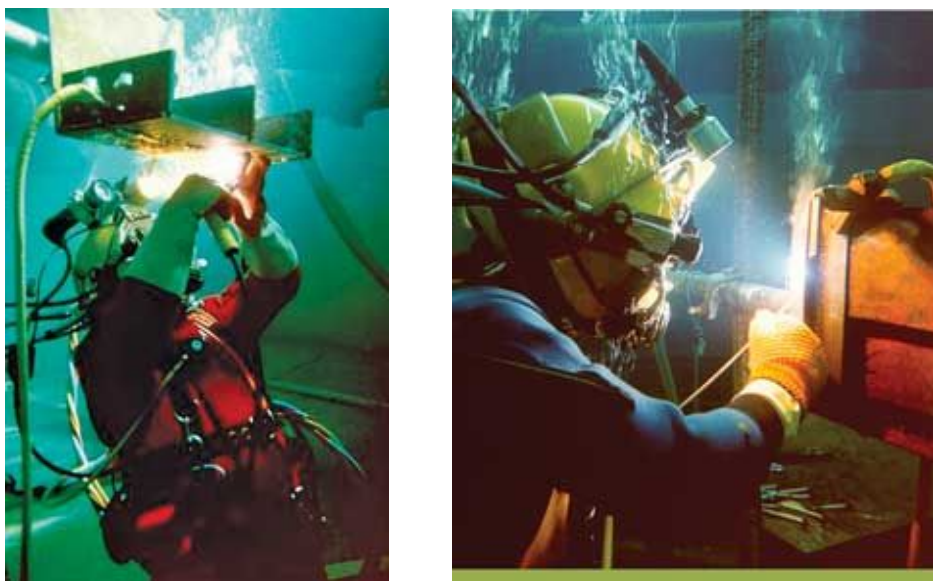
Slike 2.3.10 Nadglavno i vertikalno zavarivanje [51]
