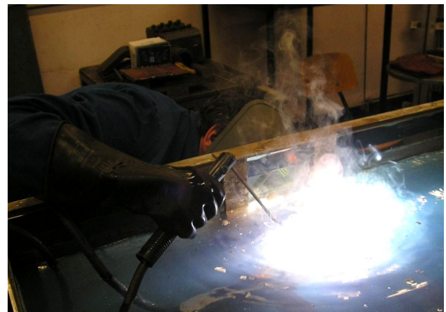
Slika 3.5.7 Podvodno REL zavarivanje ispitnog Y-spoja
