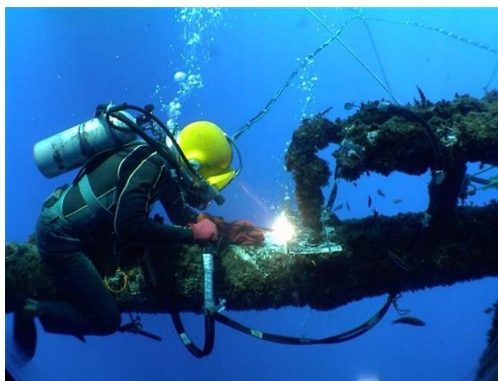
Slika 2.3.4 Mokro podvodno zavarivanje [47]
