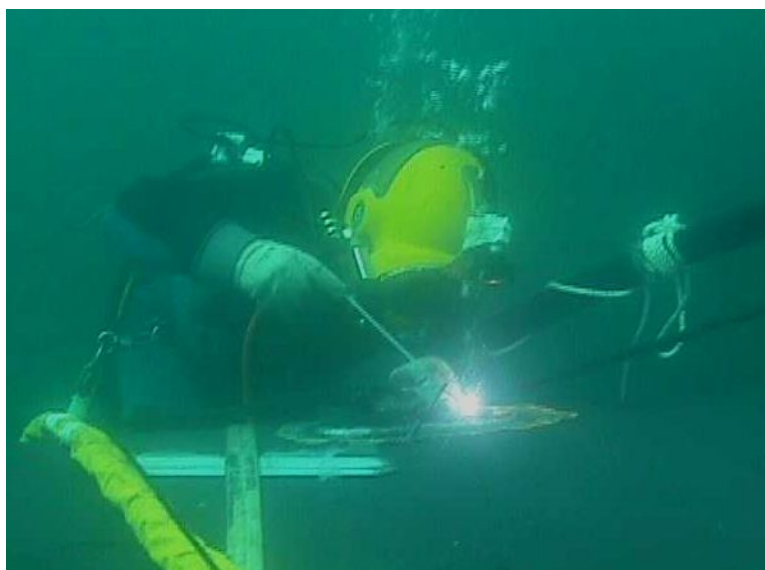
Slika 2.3.11 REL mokro podvodno zavarivanje [44]
