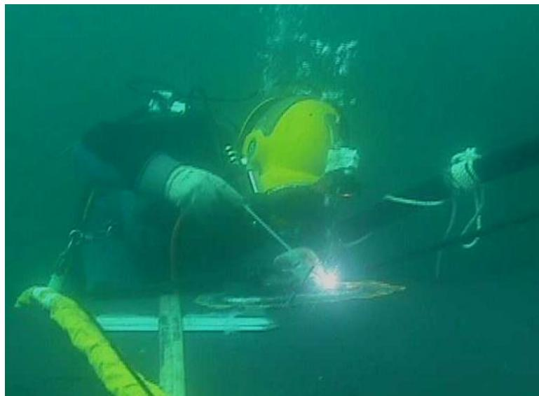
**Slika 2.3.11 REL mokro podvodno zavarivanje [44]**
