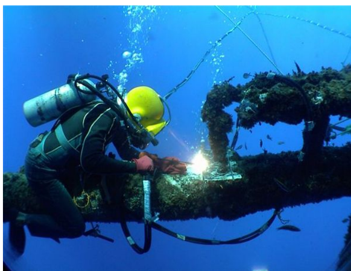
Slika 2.3.4 Mokro podvodno zavarivanje [47]
