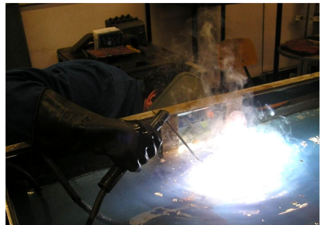
Slika 3.5.7 Podvodno REL zavarivanje ispitnog Y-spoja
