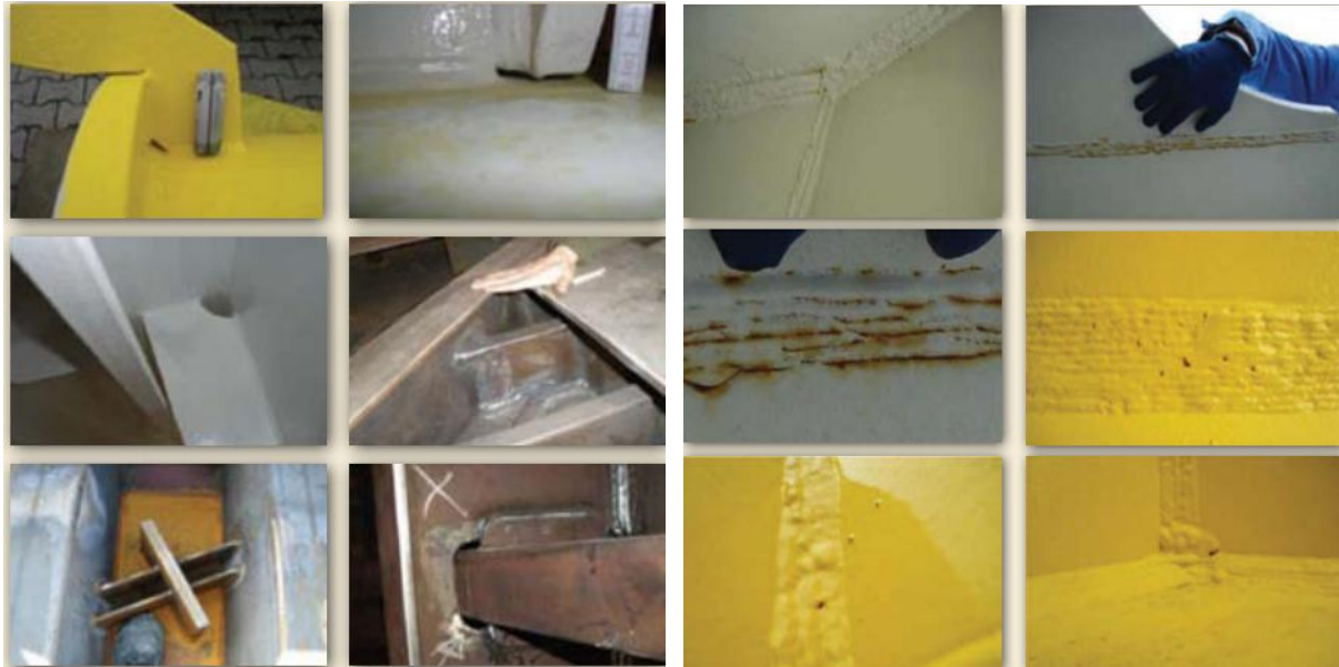
Slika 16. Priprema zavara konstrukcije vjetroelektrane za aplikaciju boje [17]
