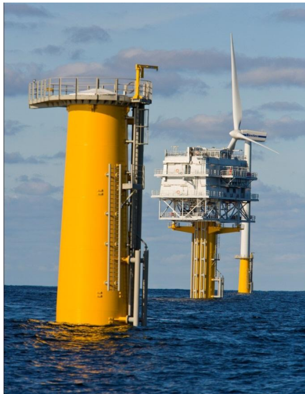
Slika 14. Čelični tornjevi vjetroturbina [16]
