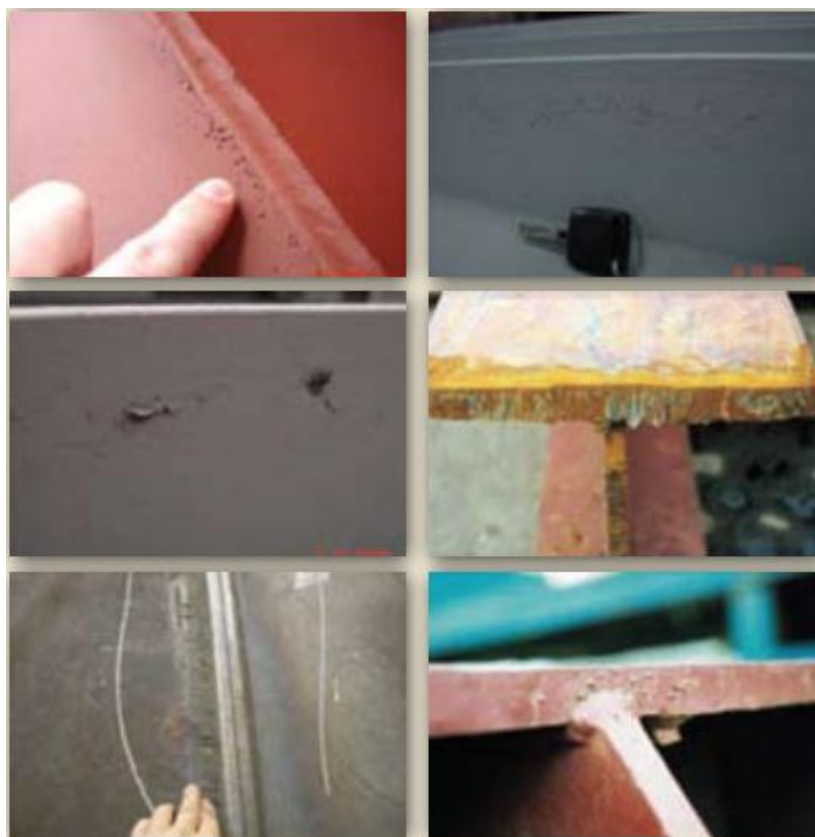
Slika 15. Priprema rubova konstrukcijskih dijelova vjetroturbina [17]
