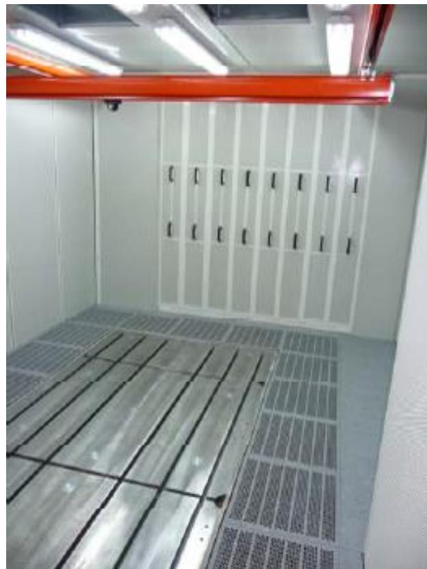
*Slika 10.4. Kabina s elastično uležištenim temeljom na zračnim oprugama*
