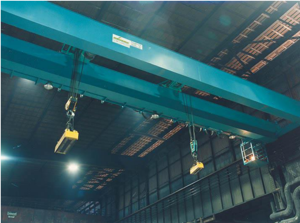
Slika 5. Dizalica u zavarivačkoj radionici [5]
