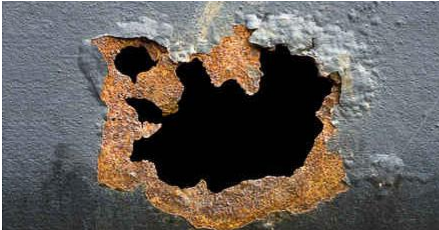
Slika 2. Šteta nastala korozijskim djelovanjem [3]
