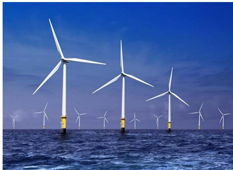
Slika 2 - Vjetroagregati s horizontalnom osi vrtnje [4]
