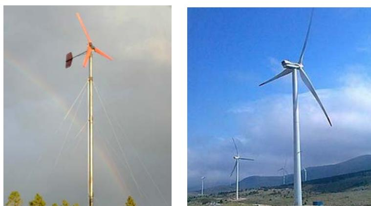
Slika 6 - Pridržani čelični (lijevo) i betonski stup (desno) [9]
