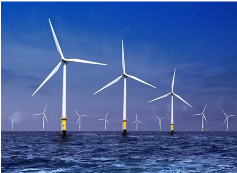
Slika 2 - Vjetroagregati s horizontalnom osi vrtnje [4]
