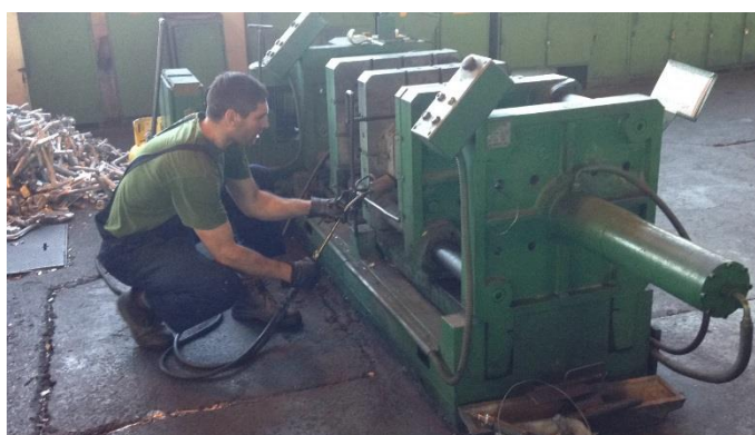
Slika 31. Montiranje plinskog brenera na nosač
