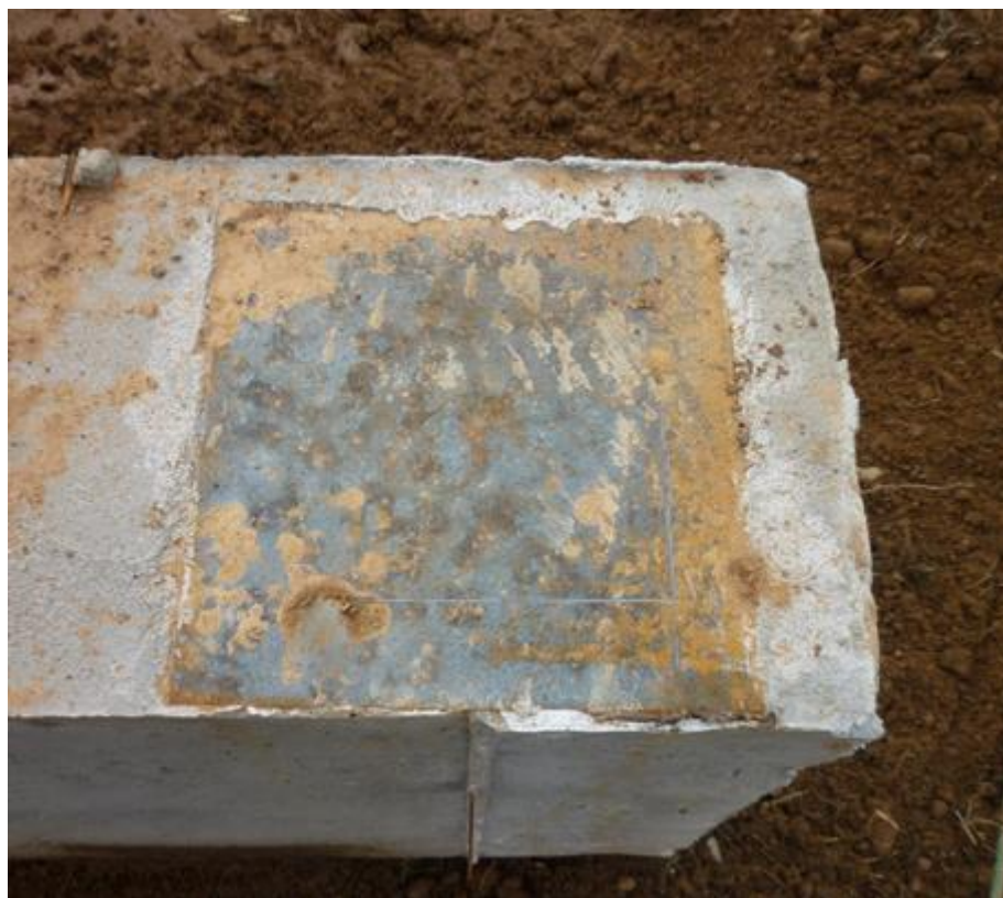
Slika 24. Temelj čeličnom pločom
