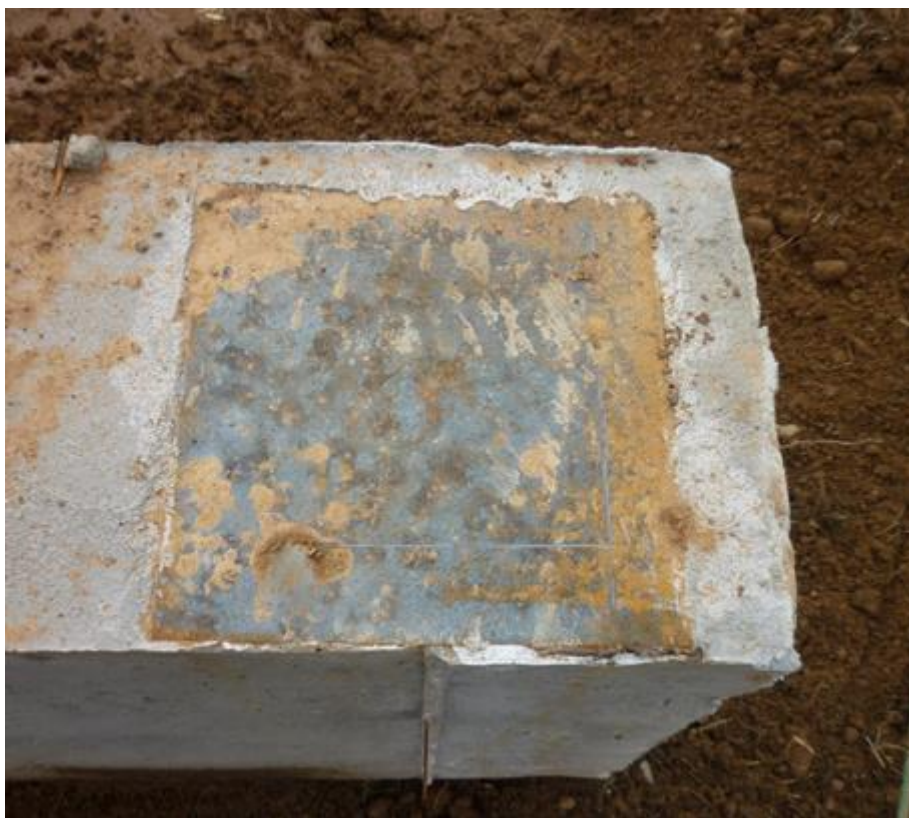
Slika 24. Temelj čeličnom pločom
