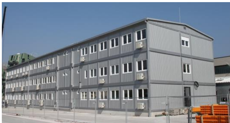
Slika 13. Modularni objekt "Wiener Netze " u Beču
