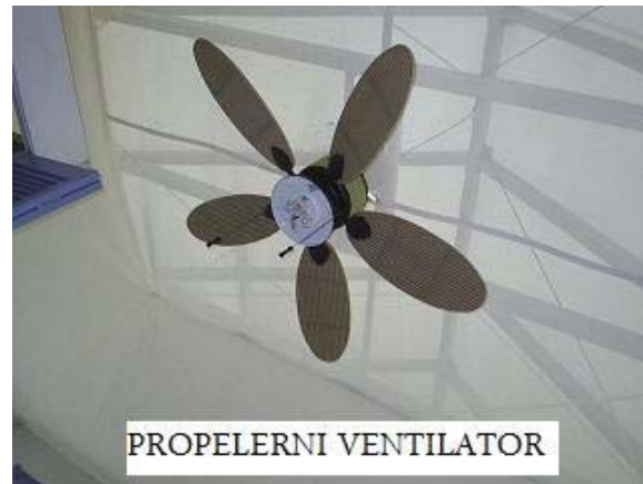
Slika 0.4. Propelerni ventilator
