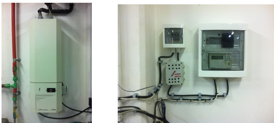
Slika 28. Električni dogrijač s regulacijom
