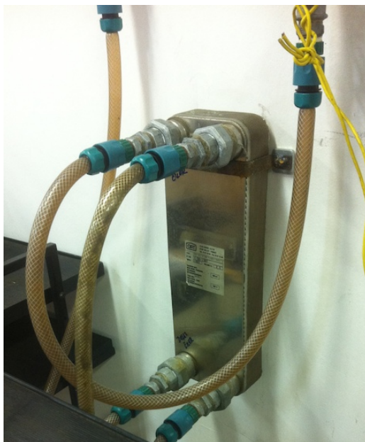
Slika 25. Pločasti izmjenjivač rashladnog kruga
