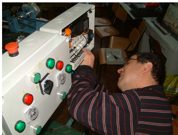
Slika 43. Montaža električnog upravljanja
