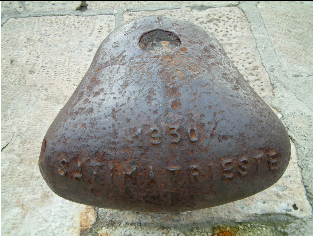
Slika 2. Opća korozija čeličnog lijeva u morskoj atmosferi
