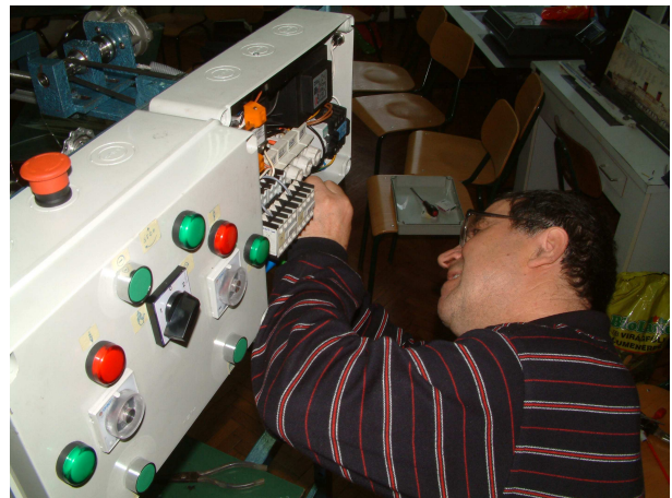
Slika 43. Montaža električnog upravljanja
