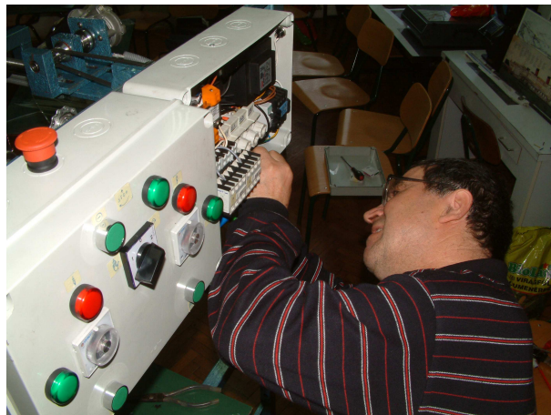
Slika 43. Montaža električnog upravljanja
