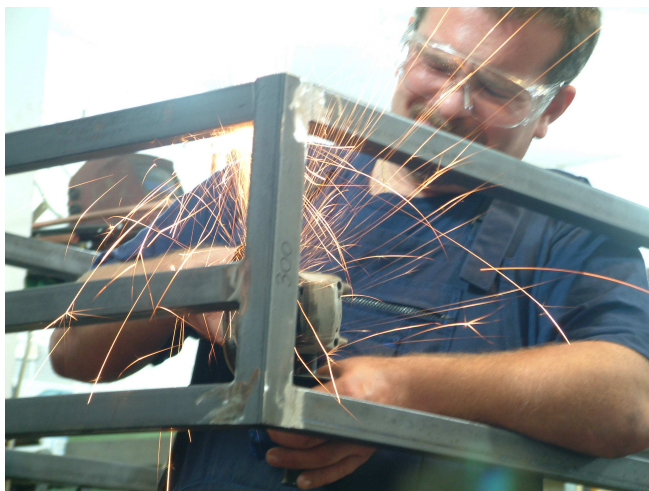
Slika 40. Brušenje zavara kutnom brusilicom
