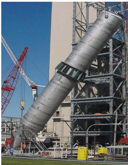
Slika 5.5. Prikaz postavljanja SSP reaktora u SSP postrojenje [32]
