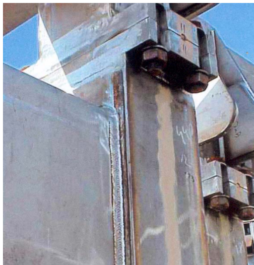
Slika 5.1. Primjer zavarivanja raznorodnih metala FCAW-om. [4]
