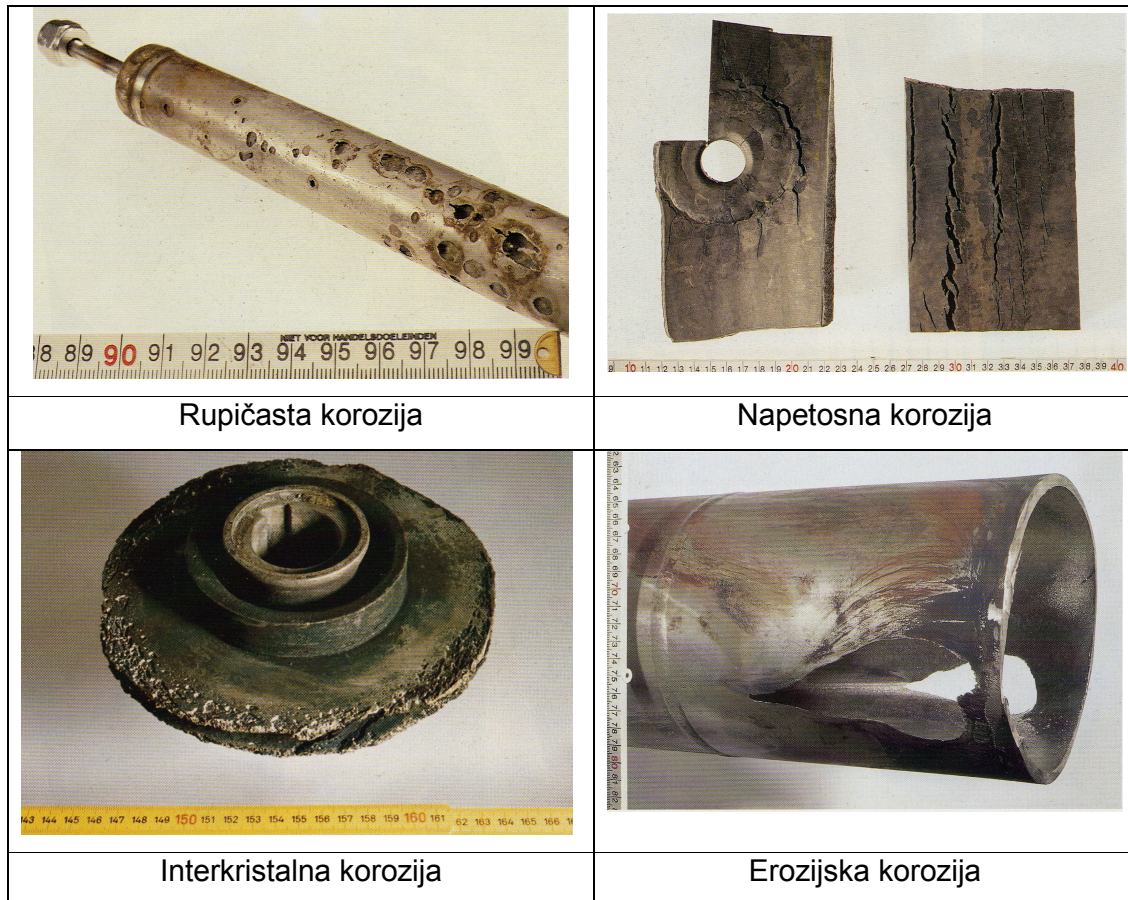
Slika 3-5 Pojavni korozijski oblici na niklu i njegovim legurama[7]
