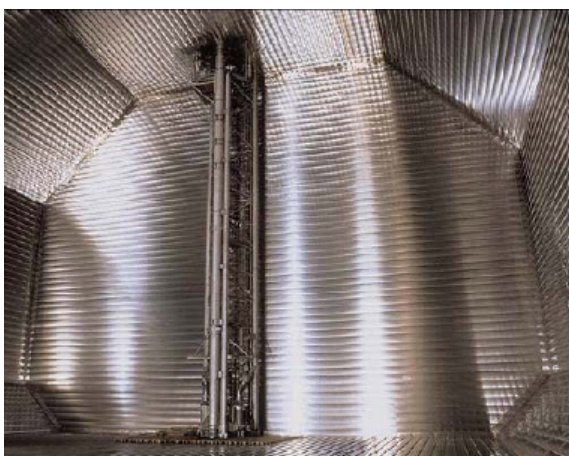
Slika 29: Pumpni toranj unutar LNG tanka i polje brzina na mjestu tornja
