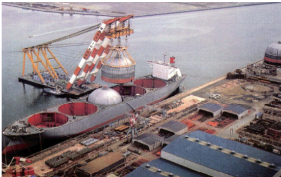
Slika 14: Ugradnja kod visoke gotovosti broda, čime se osigurava bolji nadzor kvalitete izrade i kraći rokovi isporuke
