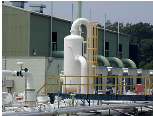
Slika 5: Pogon za ponovno ukapljivanje LNG-a
