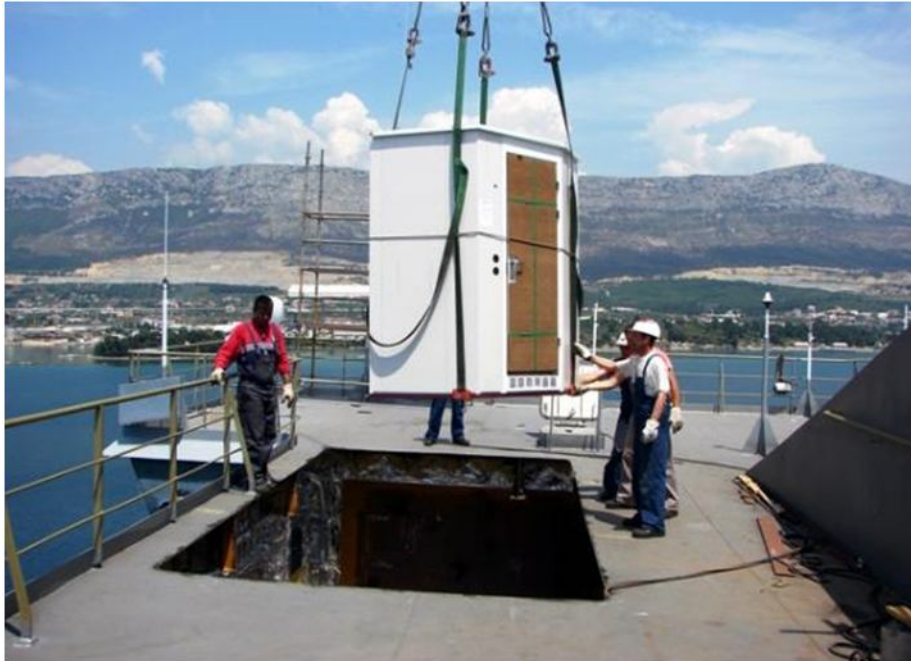
Slika 14. Opremanje na brodu prije zatvaranja broskog prostora
