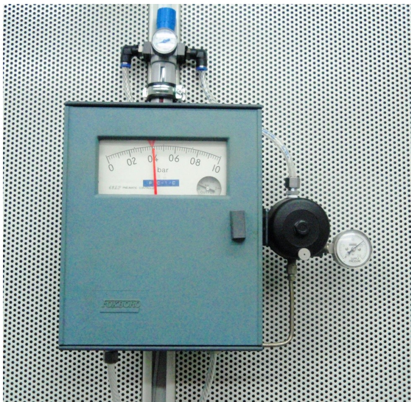
Slika 4.10. PID regulator tlaka FOXBORO
