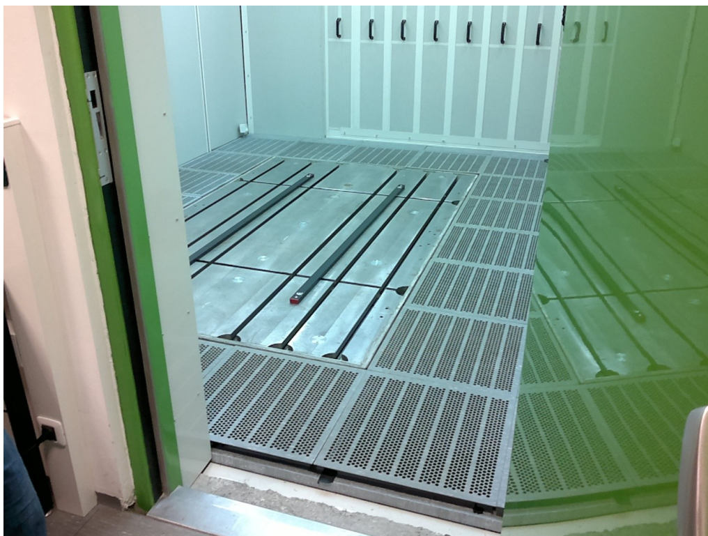
Slika 3.2. Temeljna ploča u ispitnoj stanici Laboratorija za motore i vozila
