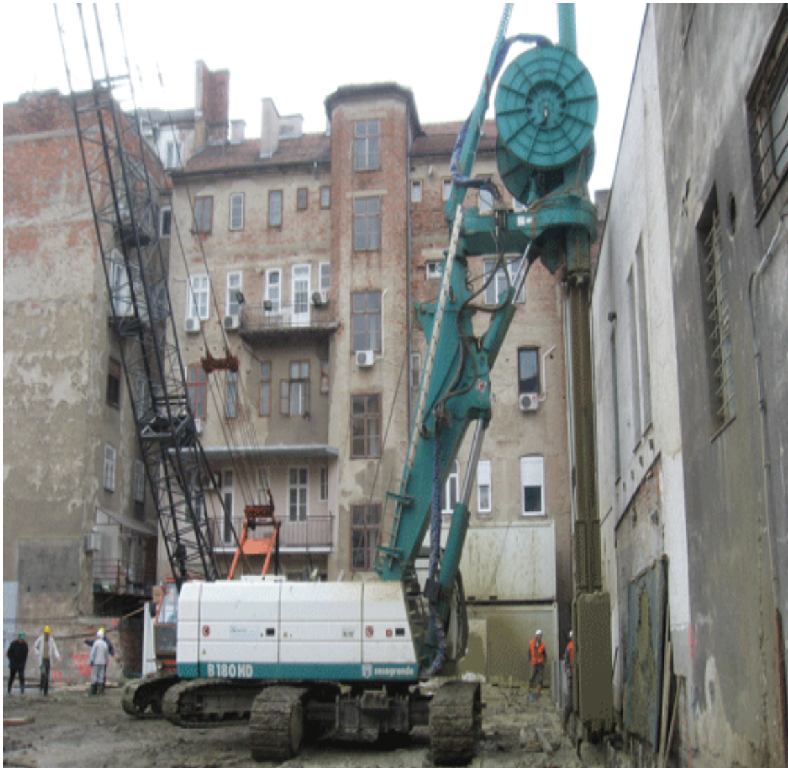
Slika 3.2 Primjer radova za osiguravanje iskopa od urušavanja
