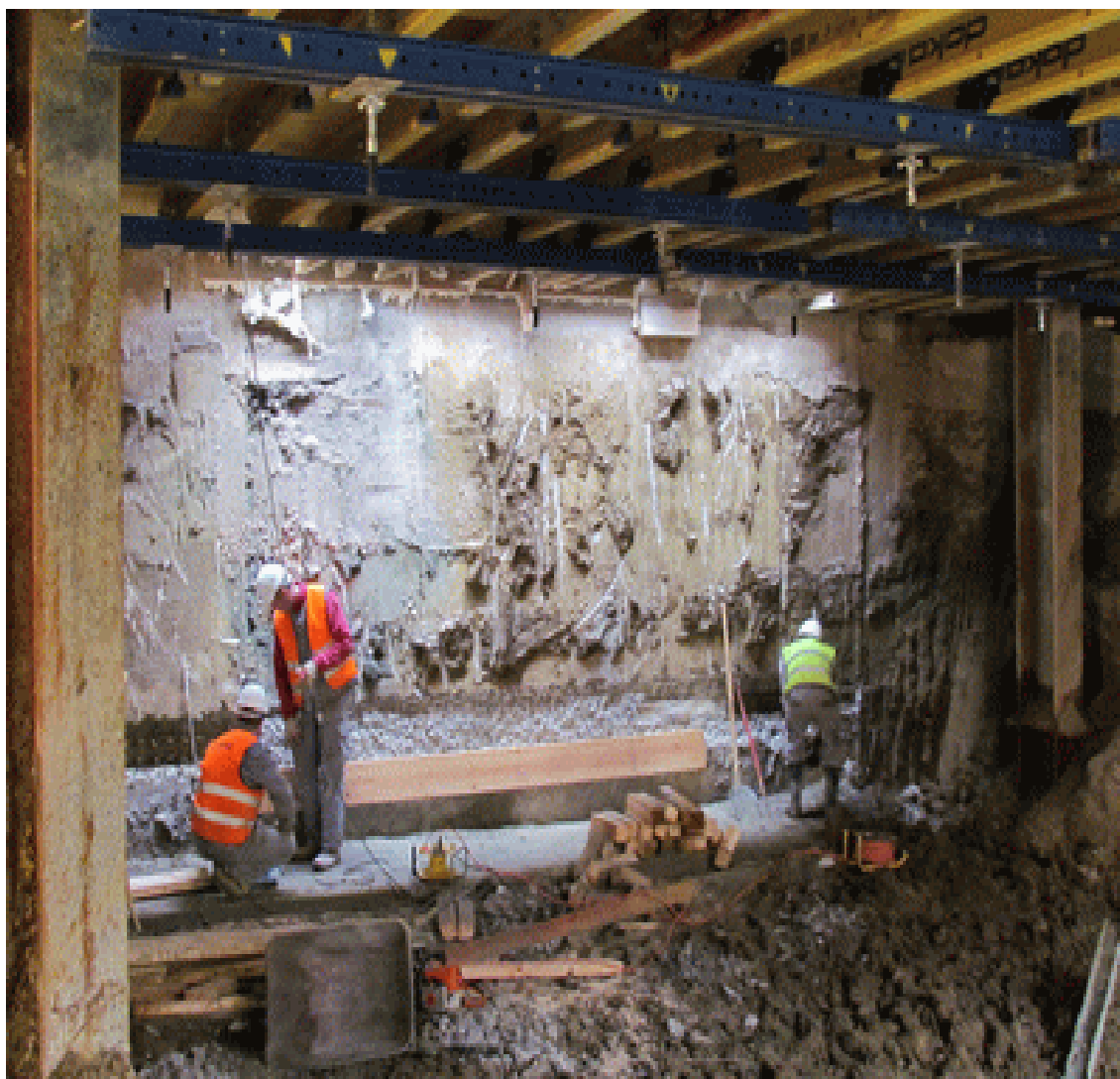
Slika 3.1 Radnici unutar iskopa
