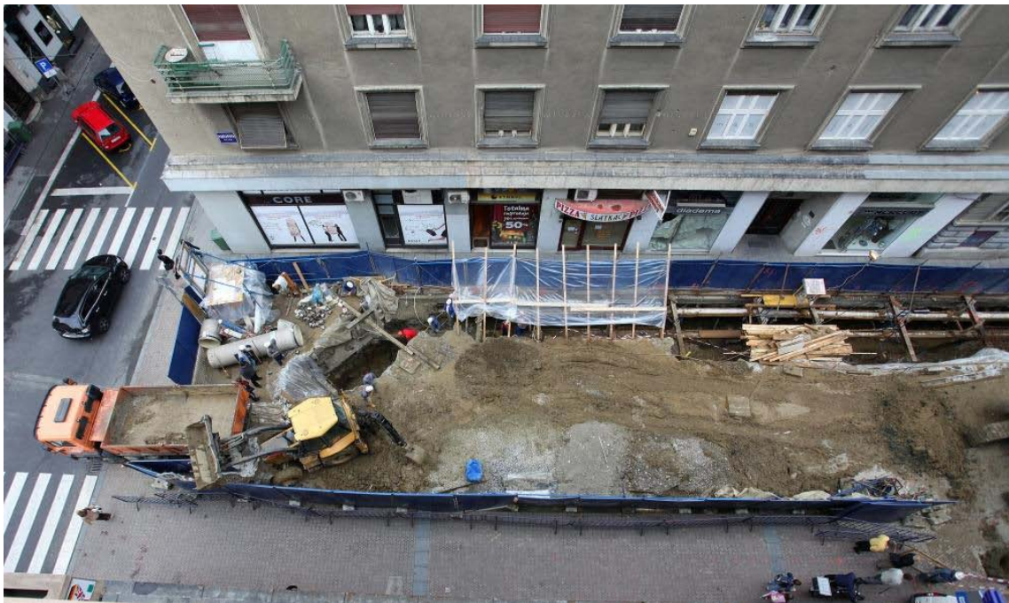
Slika 1.1 Primjer građevinskog iskopa
