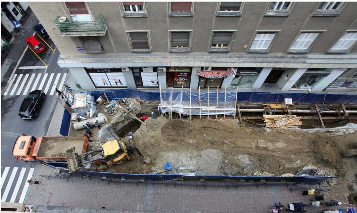
Slika 1.1 Primjer građevinskog iskopa
