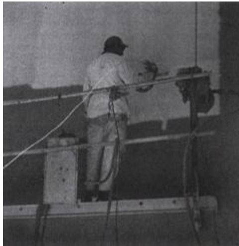
Slika 18. Metalizacija - jedan od postupaka primjene cinčanih prevlaka [11]
