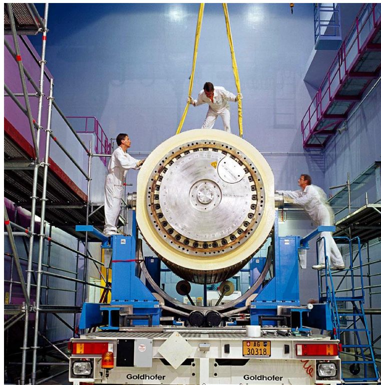
Slika 16. Postavljanje spremnika na prikolicu [17]
