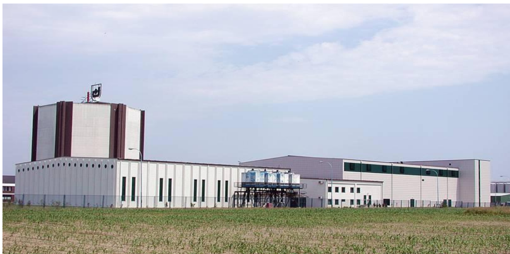
Slika 5. Industrijski pogon: toranj, skladište gotove robe, proizvodni pogon [21]
